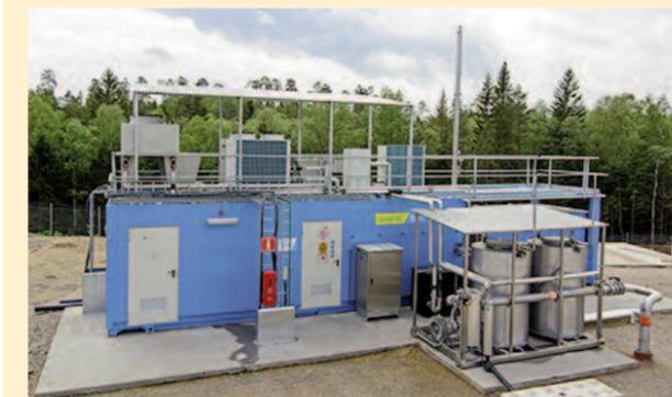
Sistema de depuración de biogás Carborex para inyección en la red o para uso como combustible en vehículos
