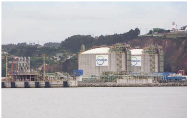
cubic meters) de capacidad al año de GNL a la seguridad de suministro energético europeo. Permitirá el atraque de buques de entre 50.000 y 266.000 metros cúbicos, cuenta con dos tanques de 150.000 metros cúbicos de capacidad de almacenamiento de GNL, dos cargaderos de cisternas con capacidad para cargar un máximo de 9GWh/d y una capacidad de emisión máxima de 800.000 Nm<sup>3</sup>/h. •
