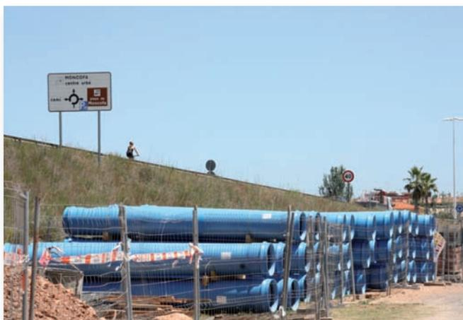
Figura 3. Acopio Tubería TOM® de PVC-O.
