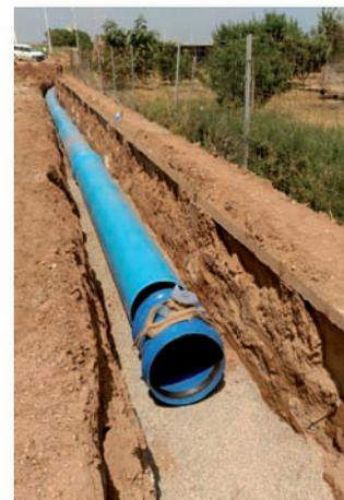
Figura 2. Tubería TOM® de PVC Orientado DN 630 mm.
