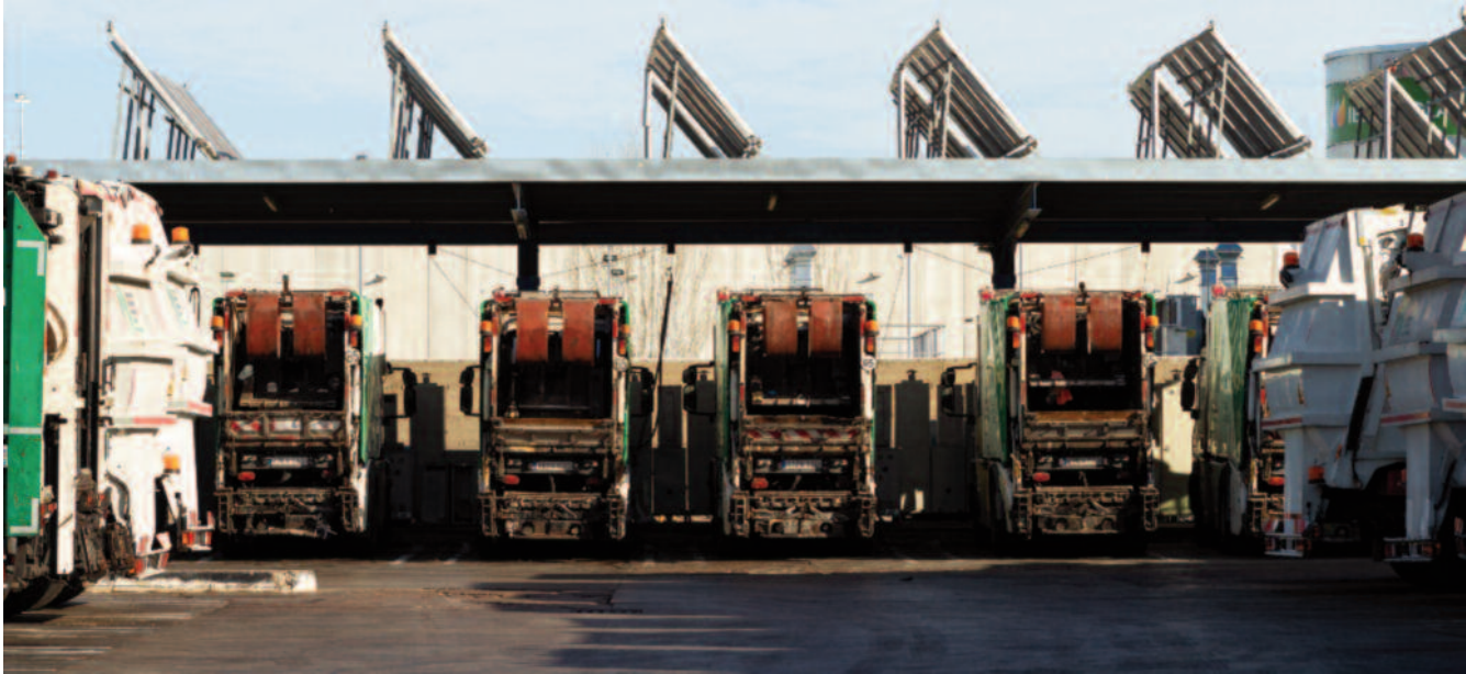
Instalaciones de captación de energía con paneles solares para autoconsumo sobre las marquesinas de recarga de la flota eléctrica de recogida de residuos de la Delegación de Barcelona Capital y Baleares de FCC Medio Ambiente
