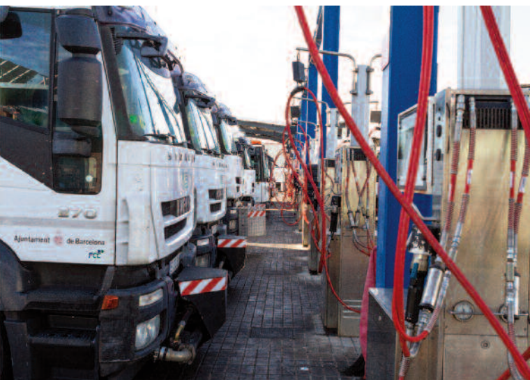
Instalaciones de abastecimiento de GNC para los vehículos de limpieza y recogida de residuos de la Delegación de Barcelona Capital y Baleares de FCC Medio Ambiente
