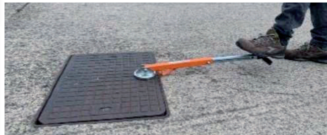
Desbloqueo tapa mediante apoyo central
