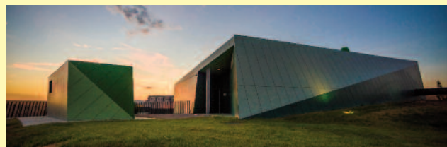
Central de recogida de Lezcairu (Pamplona)
