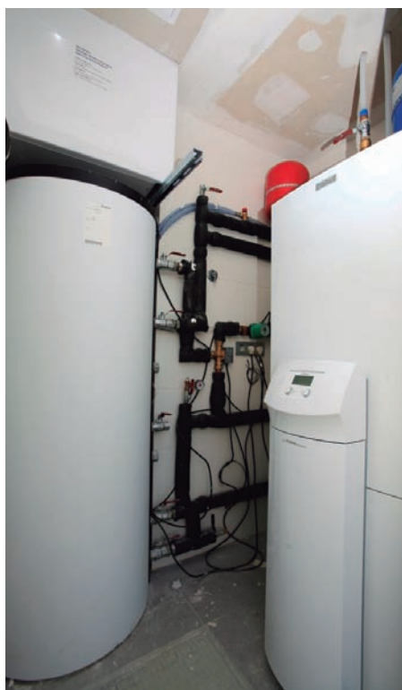
Bomba de calor geotérmica junto al acumulador multi-energía y el sistema de ventilación mecánica controlada
