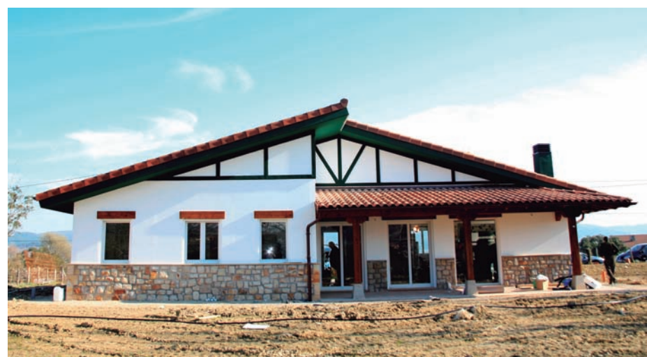
Vivienda en su última fase de construcción
