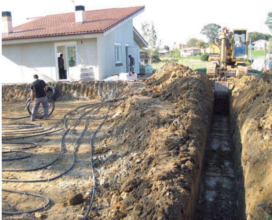
Colocación de captación horizontal y zanja del pozo
