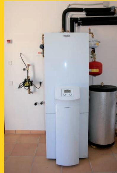
El sistema para la producción de agua caliente permite calentar el acumulador de 175 litros en menos de 20 minutos (desde 10 °C a 55 °C).
