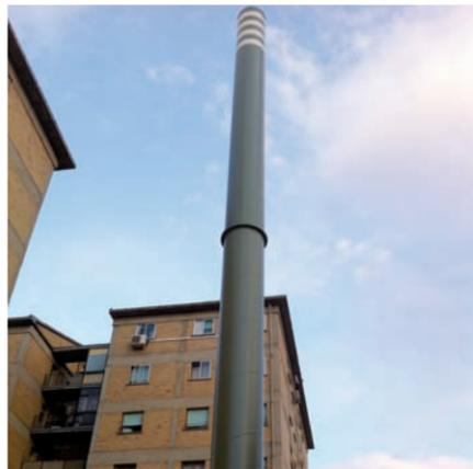
Jeremias España S.A., en colaboración con Giroa S.A.U., ha realizado el diseño, fabricación e instalación de los sistemas de chimeneas para el nuevo 'District Heating' instalado en el Barrio de Lourdes en Tudela (Navarra). Se trata de una instalación centralizada para dar servicio de calefacción de 31 portales y 486 viviendas dentro del barrio.
