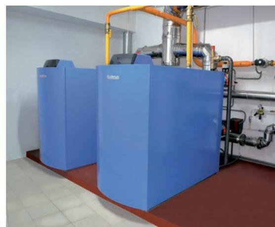
hasta un 110 por 100 y, además, destaca por su funcionamiento silencioso, trabajando en la sala de caldera a menos de 60 dB, en el modelo de mayor potencia de la gama y a plena carga.
