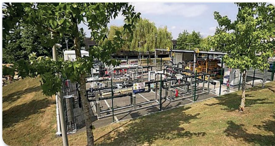
**N** ortegas ha finalizado con éxito la tercera fase de pruebas de su proyecto H2Sarea en la que ha inyectado una mezcla del 15 por 100 de hidrógeno y 85 por 100 de gas natural en una réplica a escala de sus redes de distribución.
