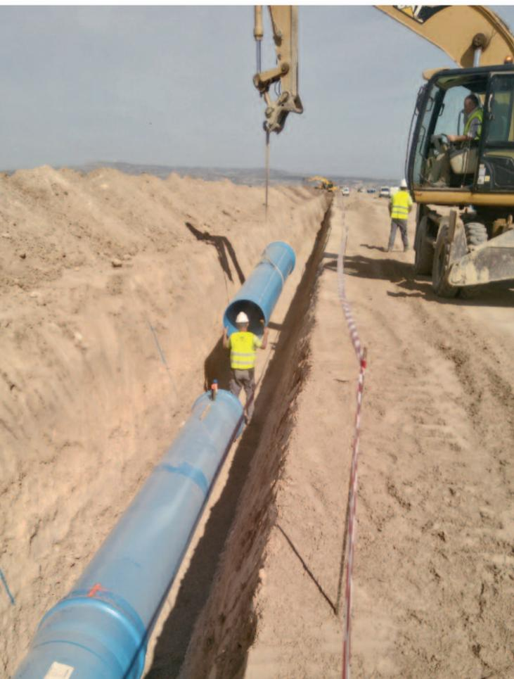
Figura 1. Instalación tubería TOM de PVC-O
