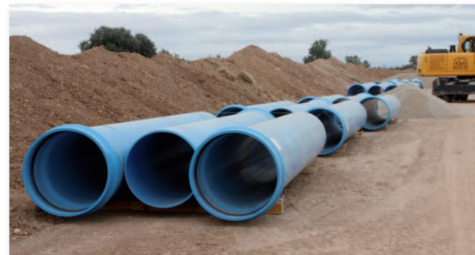
Figura 4. Acopio tubería TOM DN800 mm
